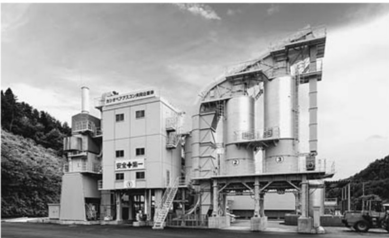
完成したアスファルトプラント (提供・カシオペアアスコン共同企業体)
